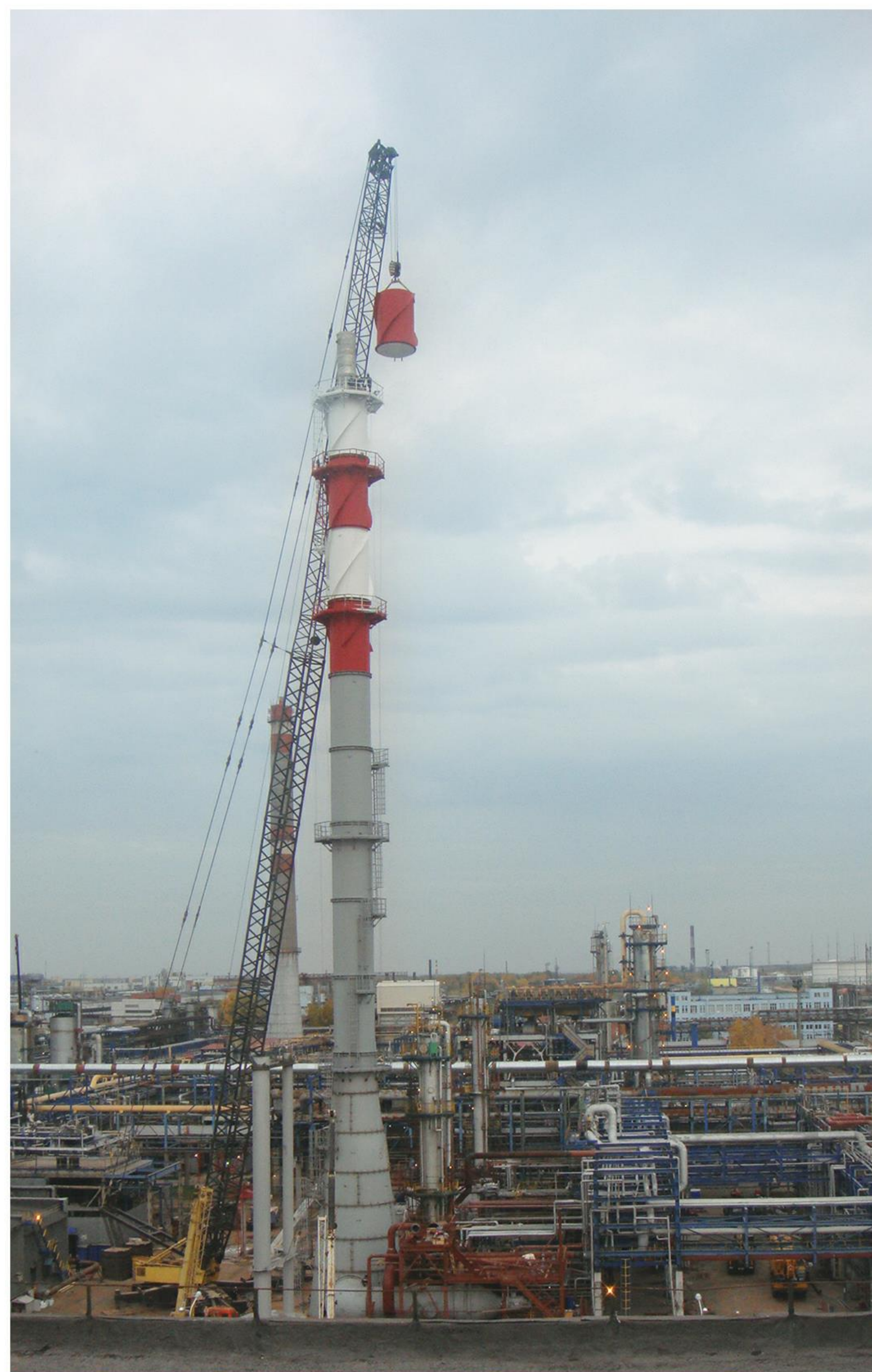
Монтаж дымовой трубы ВА-604 (труба высотой 84 метра) ОАО «ТАИФ-НК», г. Нижнекамск
